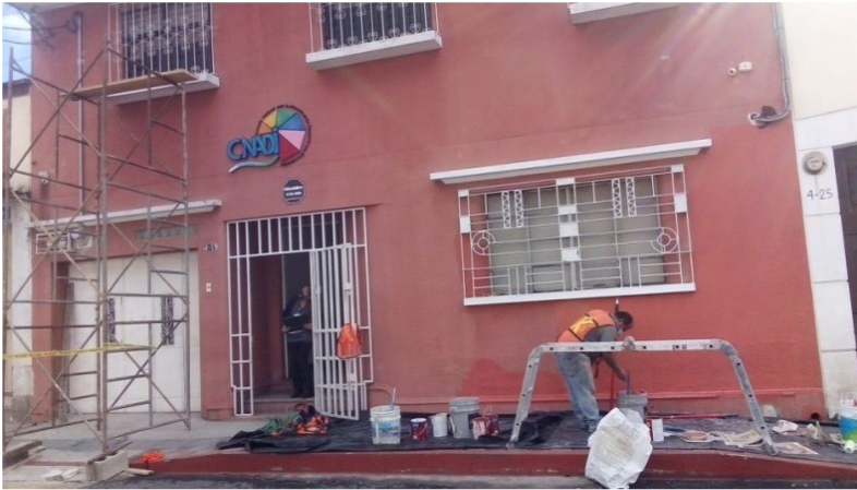
Fotografías Aplicación de pintura oficinas de CONADI
